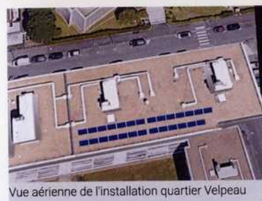
Vue aérienne de l'installation quartier Velpeau
