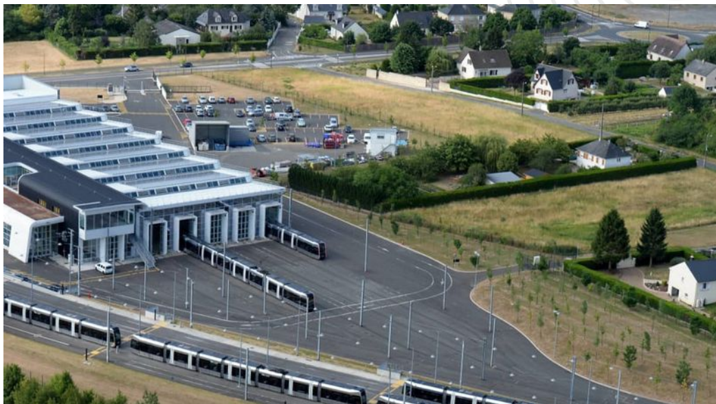
Centre de maintenance du tramway (Tours)
