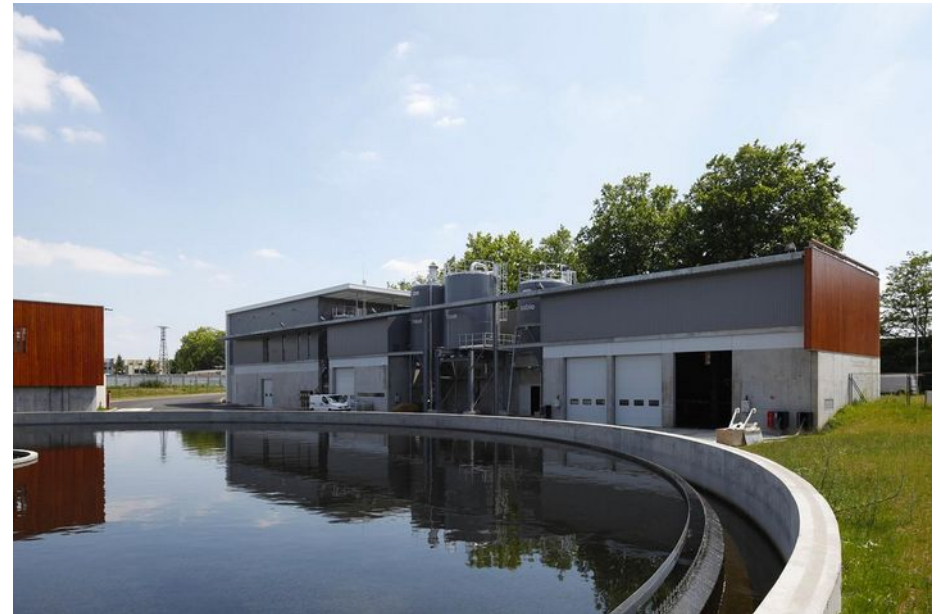
Station d'épuration (Orléans La Source)
